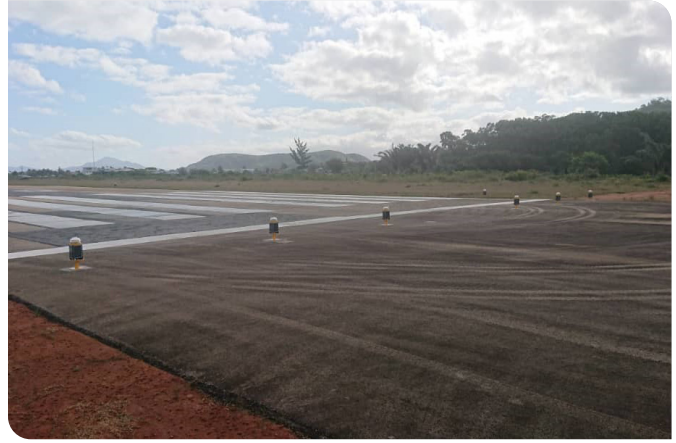
Las versátiles luces de umbral AV-426, cumplidoras con ICAO y FAA AV-426 en montajes frangibles identifican el inicio/final de una pista de aterrizaje.
