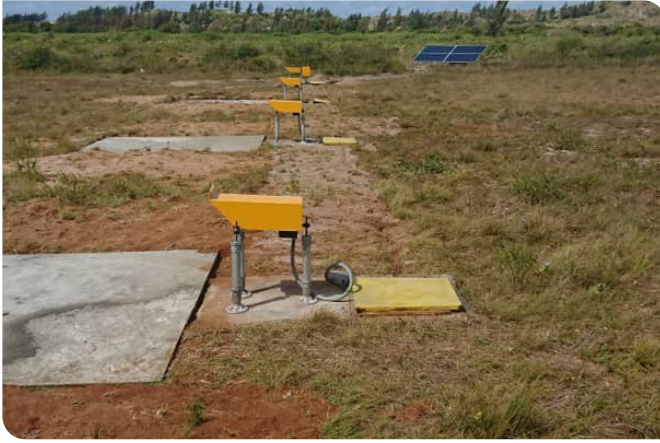
Indicador de trayectoria de aproximación de precisión LED de Avlite (PAPI) Serie 3 con paneles solares en el fondo para instalaciones ICAO.
