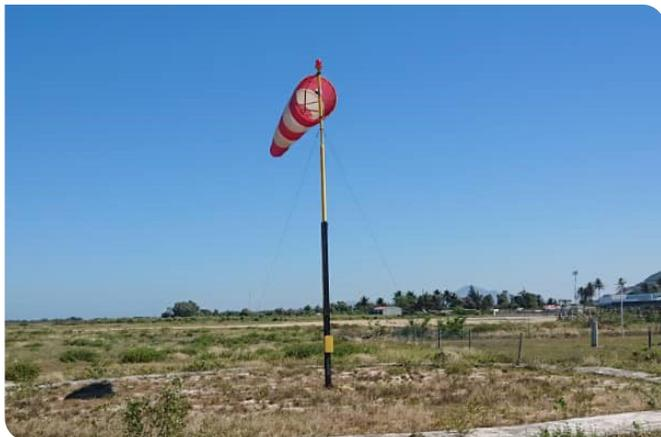
Les cônes de vent L-807 à éclairage interne fournissent la direction du vent de surface aux avions en approche.
