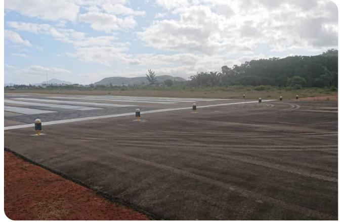
Les feux de seuil AV-426, polyvalents et conformes aux normes de l'OACI et de la FAA, installés sur des supports frangible, identifient le début/la fin d'une piste.
