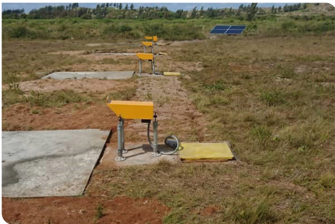
Indicador de Trajetória de Aproximação de Precisão em LED (PAPI) Série 3 da Avlite com painéis solares de fundo para instalações da OACI.
