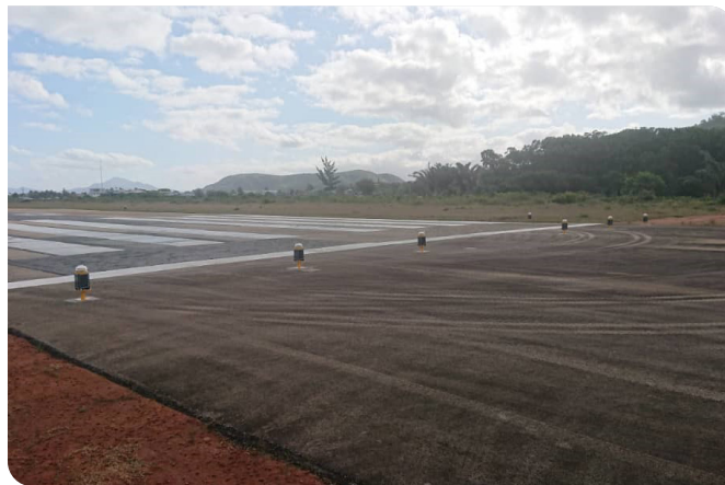
As versáteis Luzes Limiares AV-426 compatíveis com a OACI e FAA com suportes frágeis identificam o início / fim de uma pista.
