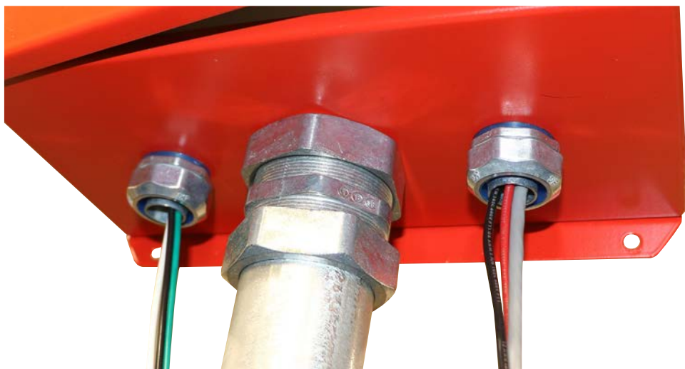
Cables de conexión AC desde la PCU
