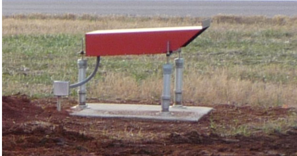
Exemple d'un LHA installé
