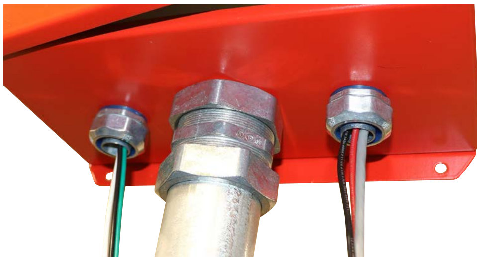
Câbles de connexion CA à partir de la servocommande
