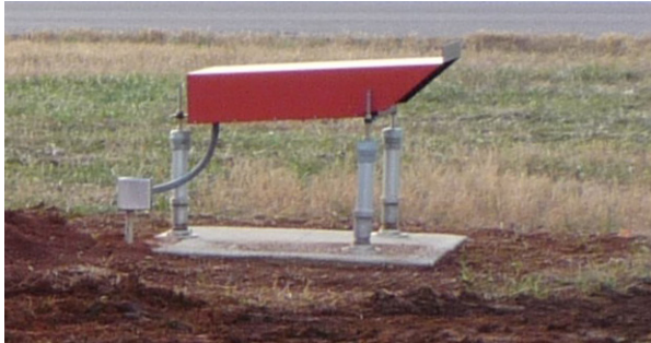
Exemplo de uma LHA instalada
