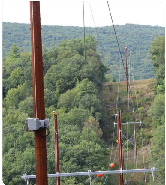
Cada torre de la línea de transmisión de 69kV lleva el Kit de iluminación de obstrucción A-0 de Avlite, que consta de dos lámparas L-810 en la parte superior y una unidad de control en una configuración de energía solar.
