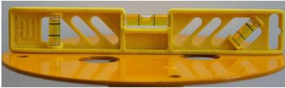
Vérifiez la plaque de montage avec un niveau à bulle dans toutes les directions
