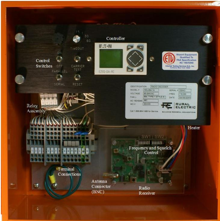
Figura 1. Radio Esquema
